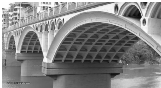
图 1 某多肋多波双曲拱桥
