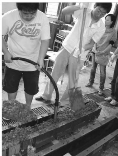
图3 学生浇筑混凝土梁
