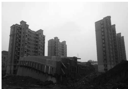
图2 上海倒楼事故现场
