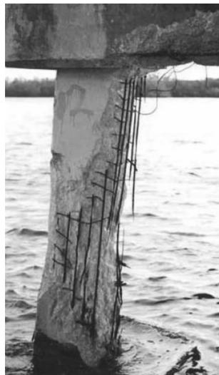
图2 严重锈蚀的钢筋混凝土柱
