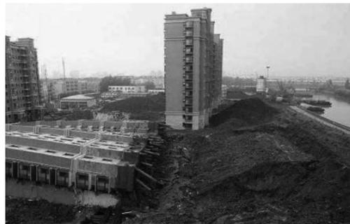
图1 上海新建住宅楼由于桩基折断造成整栋楼倾覆
