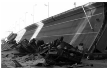
图7 哈尔滨阳明滩大桥超载垮桥图片
