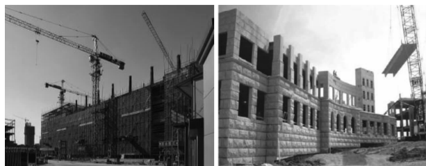
图1 现浇与预制砼结构施工现场
