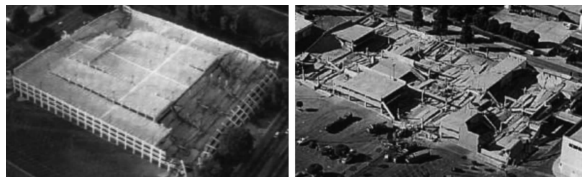
图2 预制RC结构破坏实景图
