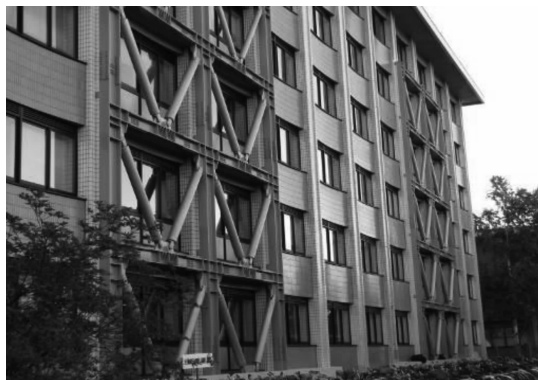
图5 日本某大学教学办公楼的抗震增强措施
