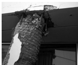
图2 柱子箍筋的环箍效应
