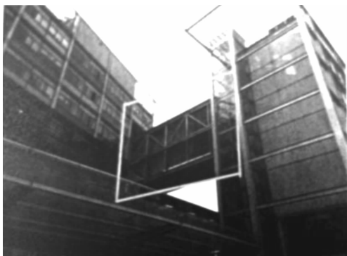
图 10 钢结构连廊实物图
