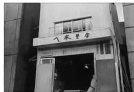
日本地震房屋整体倒塌
