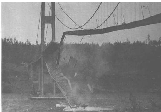
图1 塔库马大桥的倒塌现场图
