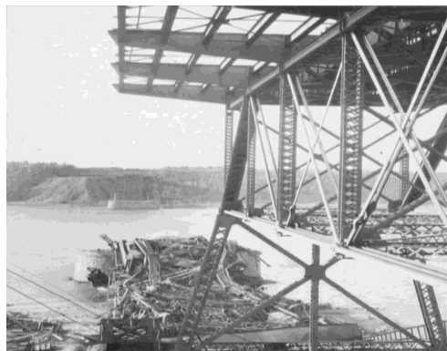
图2 魁北克大桥的倒塌现场图
