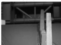
(b) 钢柱加强环板对接错边严重
