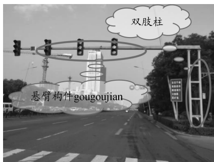
图3 信号灯钢结构
