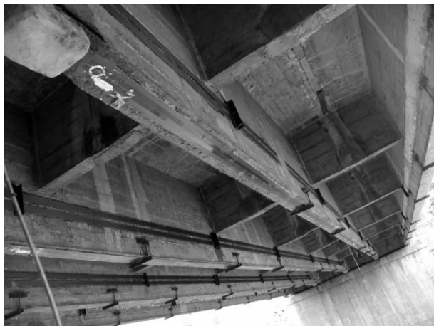
图2 FRP新材料在桥梁加固中应用图
