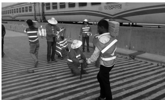
图4 FRP 加固 Bangabandhu 大桥
