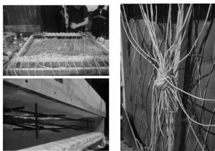
(a) 绳索约束和钢筋定位 (b) 浇筑时外部绳索约束
