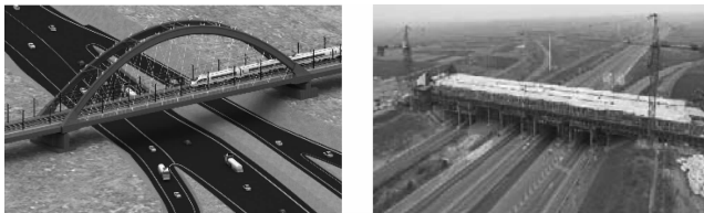
图3 系杆拱桥的BIM模型与施工现场
