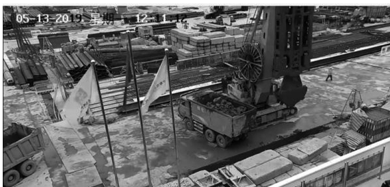
图2 地下连续墙施工过程视频
