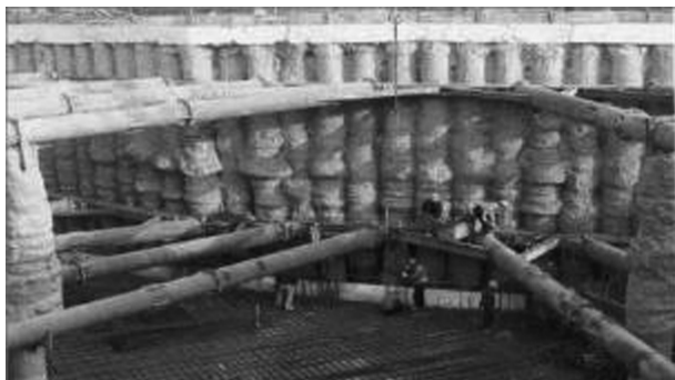
图4 基坑支护现场图片
