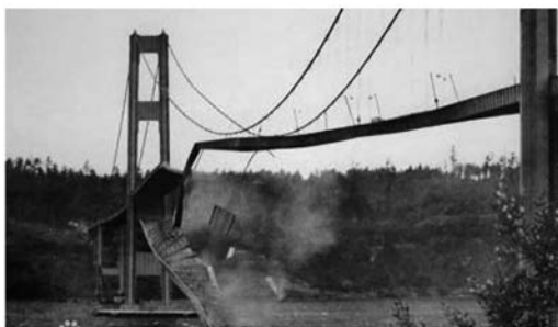
(b) 垮塌过程中的塔科马悬索桥
