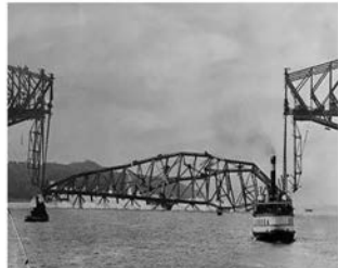
(c) 第二次坍塌事故后
