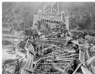
(b) 第一次坍塌事故后
