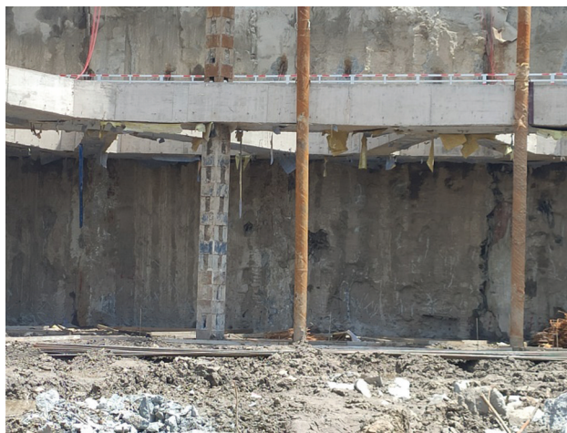
图2 地下连续墙现场实景照片
