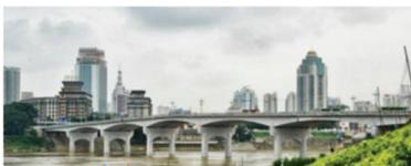
• 南宁邕江大桥, 两端跨径为45m的单悬臂梁, 中间5孔跨度各长55m, 采用23m中间挂梁的双悬臂梁。
