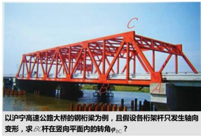
(a) 知识点: 桁架结构的位移计算
