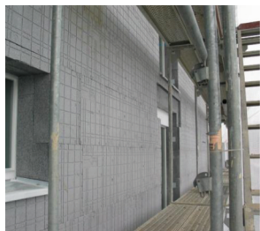
图3 建筑墙体附加保温层 [5]
