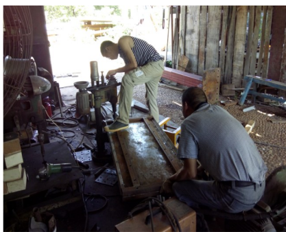
图5 夯筑模具制作图
