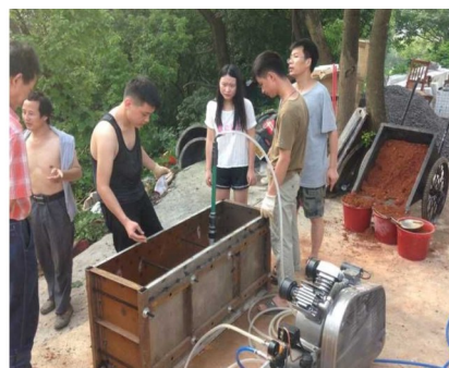
图6 夯筑试验场景图
