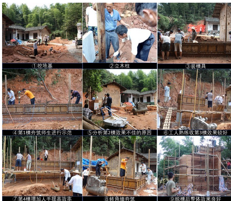
图11 夯土墙施工过程场景图
