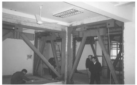
图6 粘滞消能器在工程中的应用
