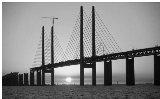
图5 厄勒海峡大桥
