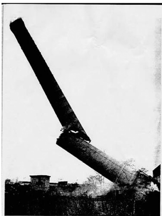
图 2 烟囱爆破倒塌的折断现象
