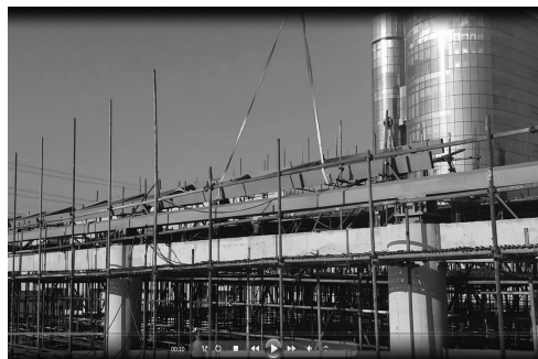
图7 大跨度管桁架施工视频截图
