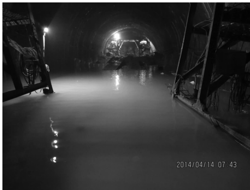
图3 隧道涌水
