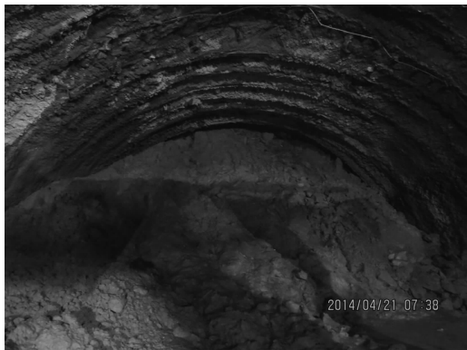
图4 隧道突泥
