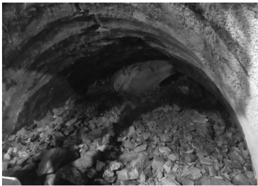
图2 隧道塌方
