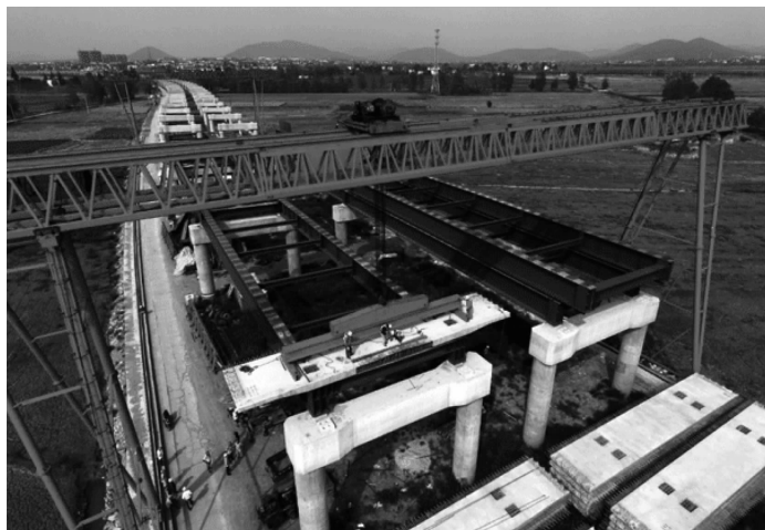
图6 钢板组合梁(工厂化预制、装配化施工)
