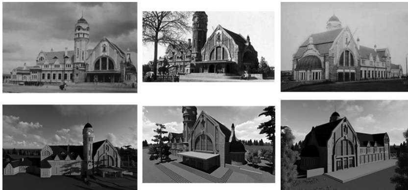
图1 根据老照片得到的“济南老火车站”修复图
