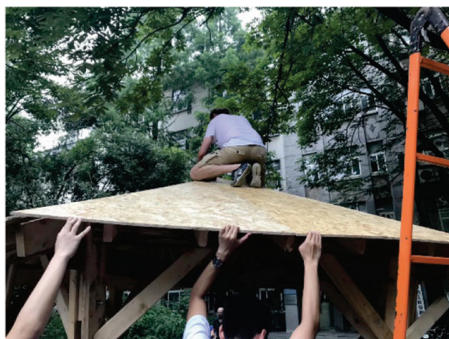
b. 木亭屋顶安装
