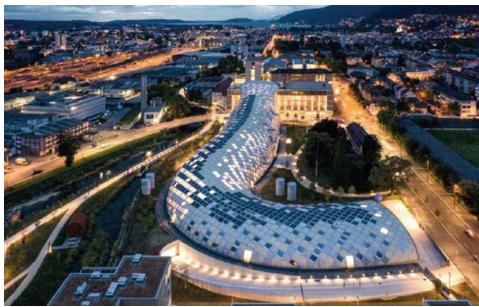
图1 Swatch在Biel的总部木结构大楼
