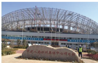
(c) 施工中的体育场
