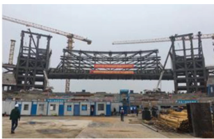
(b) 整体提升施工过程
