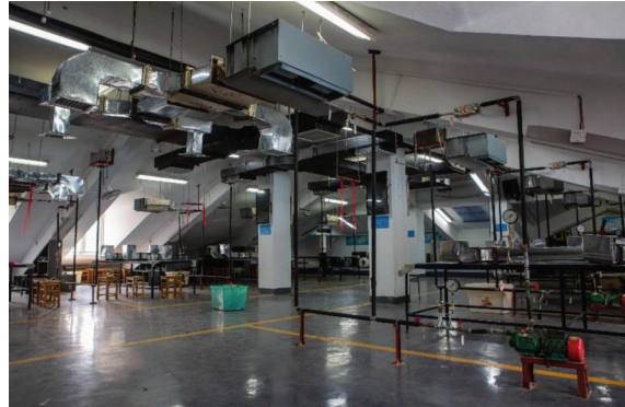
图1 南京工业大学城市建设学院实训中心
