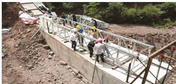
图7 “无止桥”社团学生正在修建自行设计的人行便桥
